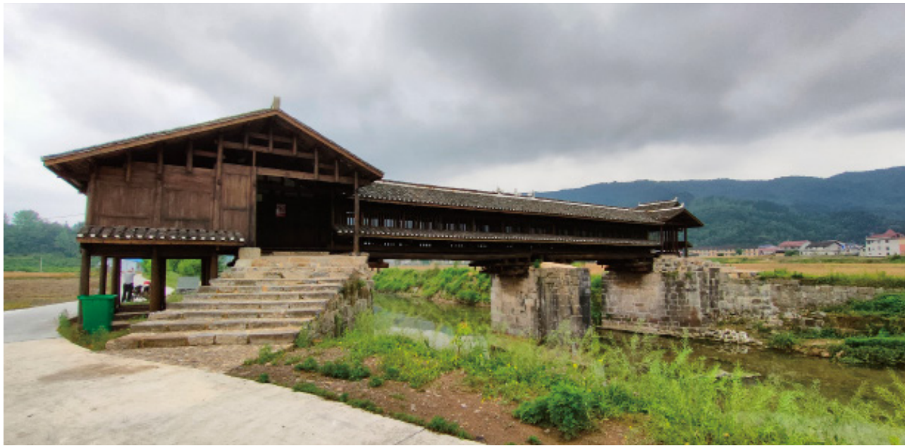
维修一新的乐安宁家桥
