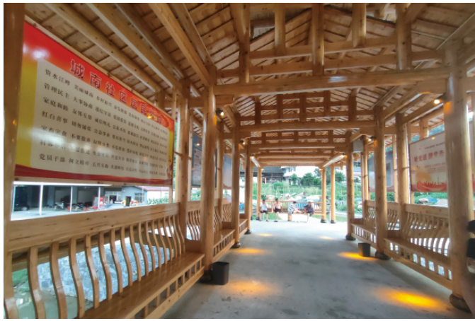
新修的县城南区铁炉冲木桥起到了良好的政策宣传作用
