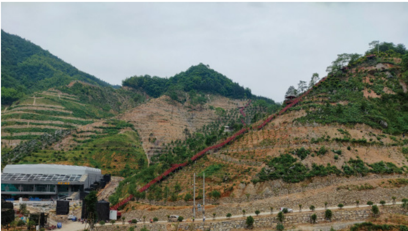
建设中的滔溪百花寨景区
